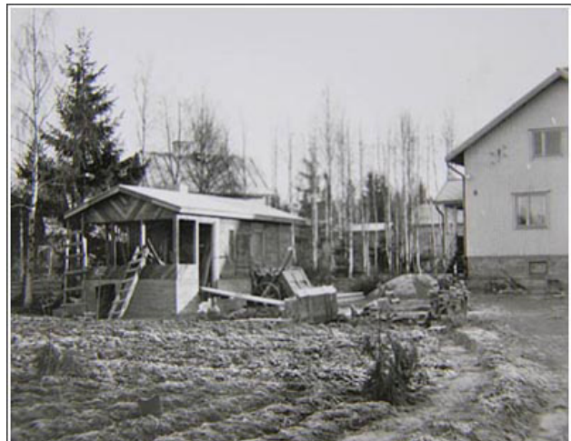
Sauna alkoi saada lopullista muotoaan kesällä 1958. Siihen lisättiin tilan jatkeeksi lasiveranta, joka tässä on rakenteilla..
