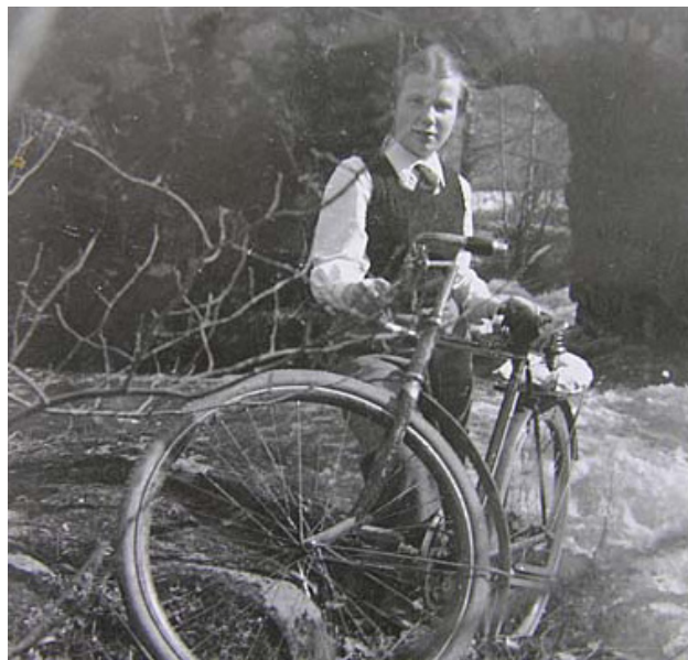
Lahja Tammelundissa pyöräretkellä. Taustalla jo purettu siltarumpu, jossa minäkin lapsena vielä seikkailin.
