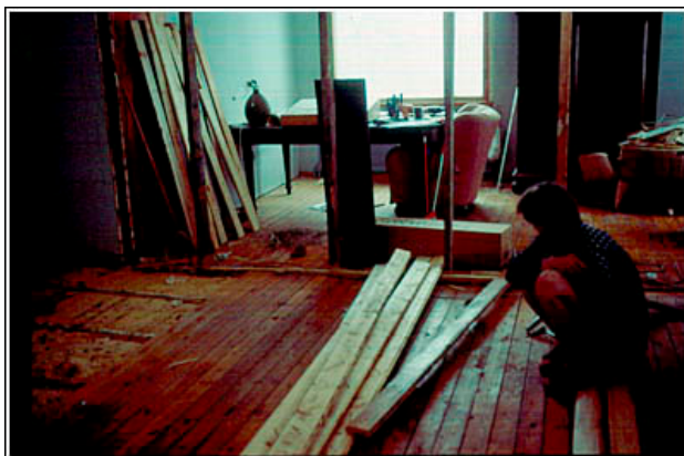
Olohuoneen väliseinä ja lattia purettiin, keskuslämmityksen putket ja patterit vaihdettiin uusiin.
