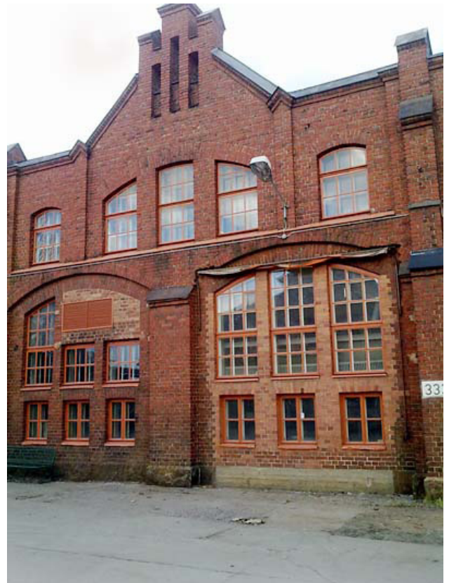
Kuvassa ei ole faijan duunimesta vaan Sturenkadun sillalta näkyneen junavarikon komeat rakennukset. Rakennusten ja Sturenkadun välissä oli runsaalla rautatavaralla kuormitetut pitkät, katetut avovarastohyllyt. Sekä rautatiekiskot että varastohyllyt on purettu. Sörnäisten radan paikalla juoksee Teollisuuskatu.
