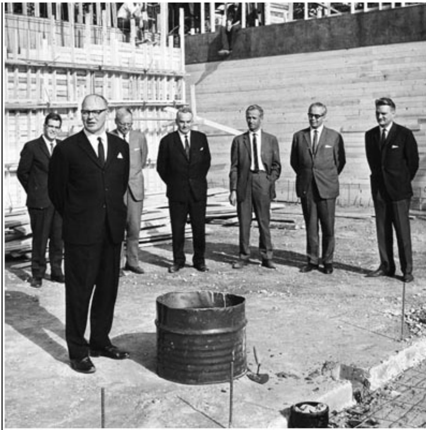
Elämä ei ollut yhtä juhlaa. Arki vaati, muun työn lisäksi, myös edustamista. Kuvassa Kiljavan opiston rakenteilla olevan kuntoskeskuksen peruskiven laskeminen vuonna 1965. Takarivissä toinen vasemmalta TPSL:n puheenjohtaja Uno Nokelainen, sitten SAK:n puheenjohtaja Vihtori Rantanen ja SAK:n toinen puheenjohtaja Viljo Kuukkanen. Oikeassa laidassa Olavi Saarinen, joka toimi urallaan muun muassa Työväen ja Pienviljelijäin Sosialidemokraattisen Liiton kansanedustajana. Kuva Työväen Arkisto.
